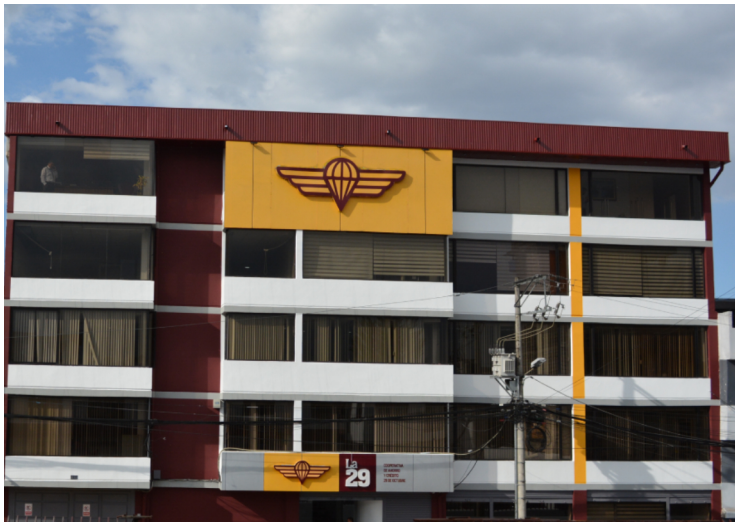
Edificio administrativo Cooperativa de Ahorro y Crédito 29 de Octubre.
